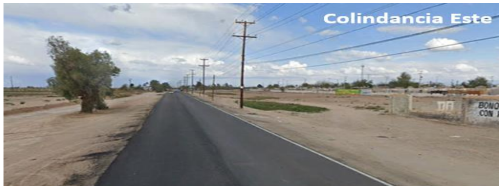
Figura 18.- Colindancia Este con Carretera Progreso -Santa Isabel, baldíos y Fracc. Villas de Alarcón.
